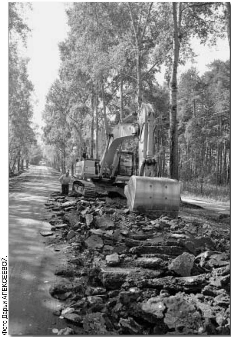
Капитальный ремонт улицы Испытателей уже начался. Сейчас здесь срезают старое дорожное покрытие, чтобы положить новое.
