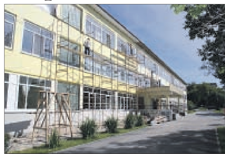
Последние штрихи ремонта в школе № 94.
