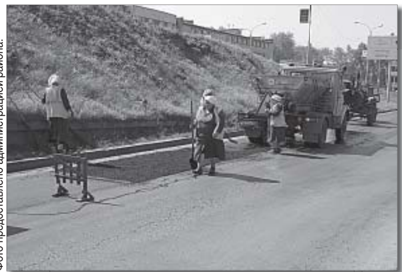
Ремонтируют на Сибирском тракте перекрытием — то есть по всей ширине проезжей части, нуждающейся в улучшении.
