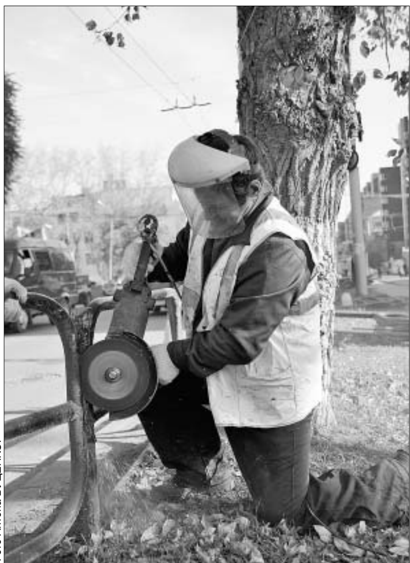
Рабочий Александр СТИХИН демонтирует ограждения на улице Декабристов. В ближайшем будущем на этом месте будут установлены новые.
